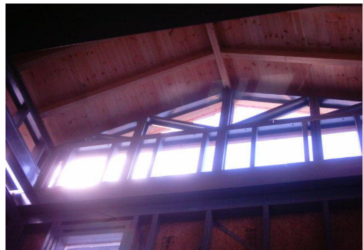
Εικόνα 7: Σύμμεικτη κατασκευή με ξύλινη σκεπή
