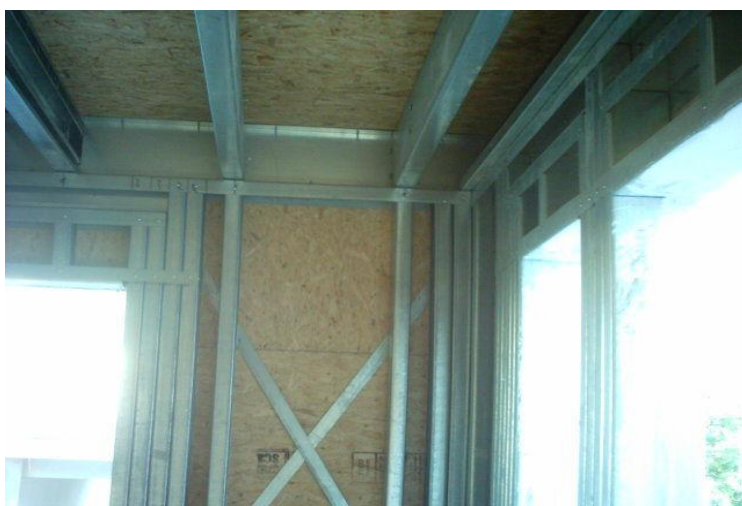
Εικόνα 8: Στήριξη δοκών πατώματος
