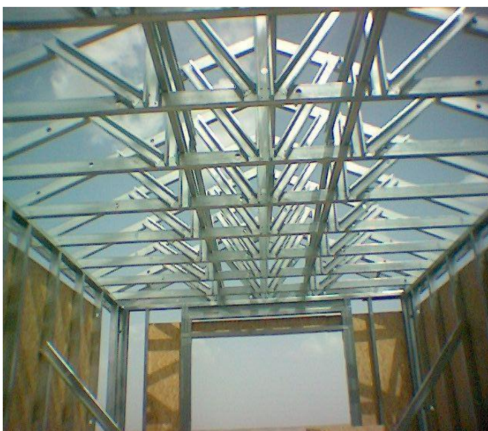
Εικόνα 3: Δικτύωμα τυπικής σκεπής
