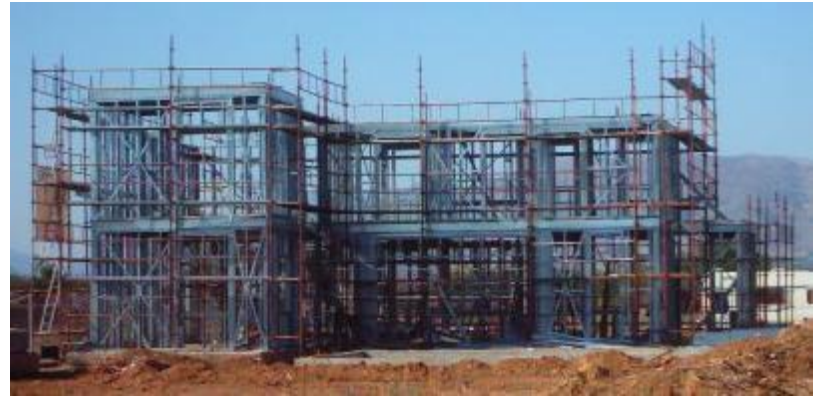
Εικόνα 2: Κατασκευή μεταλλικού σκελετού βίλας στο Ναύπλιο
